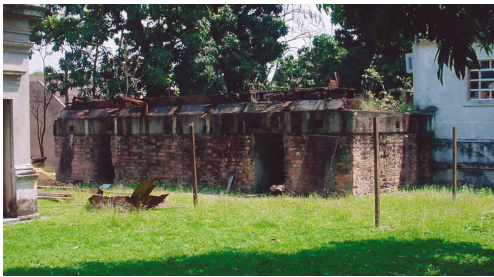
Fig. 17 - Massif en maçonnerie qui supportait le toit tonneau de l'abri du cercle méridien de l'observatoire de Rio de Janeiro, avant restauration. Le toit a totalement disparu, seuls subsistent les vestiges du plancher parqueté de la salle d'observation. Archives du Museu de Astronomia e Ciências Afins, Rio de Janeiro, Brésil © MAST.
