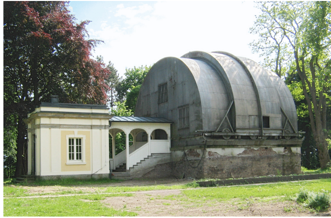
Fig. 14 - L'abri Zeiss à toit tonneau du cercle méridien Repsold de l'observatoire de Bergedorf (Hambourg - Allemagne). Vue depuis le nord-est. Photo. Marc Heller © Marc Heller, 2004.
