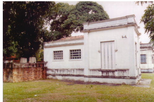
Fig. 18 - Bâtiment abritant la « pièce-vestibule ». Couloir d'accès à la salle d'observation et massif en maçonnerie qui supportait le toit tonneau de la salle d'observation méridienne, avant restauration. Archives du Museu de Astronomia e Ciências Afins, Rio de Janeiro, Brésil © MAST.
